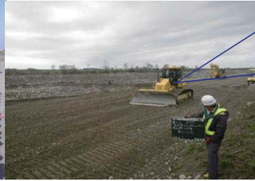
敷き均し作業は車載PCに表示された3次元設計データ のとおり施工を実施
