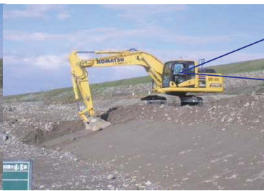
法面整形は車載PCに表示された3次元設計データ のとおり施工を実施
