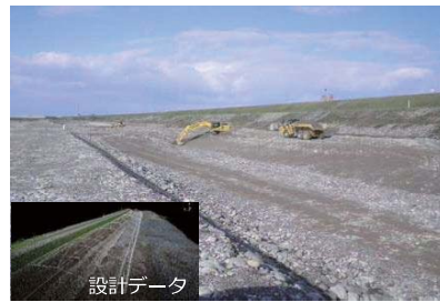
法面整形は車載PCに表示された3次元設計データ のとおり施工を実施
