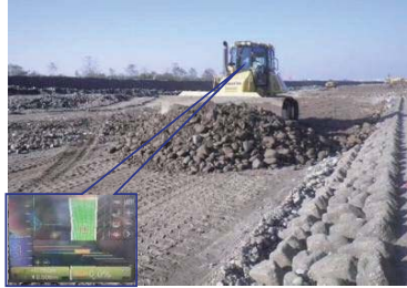
敷き均し施工範囲を表示
