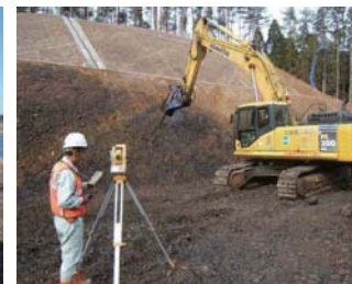
3次元設計データを用いた計測及び誘導システム 3次元設計データを用いたブレードカーによる法面整形
