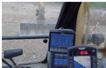
バックホウ2Dマシンガイダンスシステム 2DMGによる法面整形
