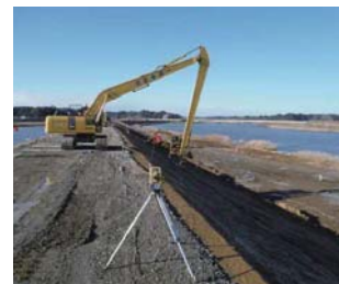
E[三](イーサン) 特許出願中 3DMGによる法面整形
