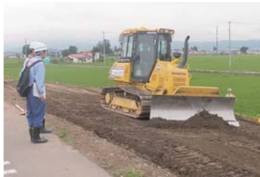
3次元設計施工データによるブルドーザのマシントロール
