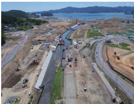
八幡川河川災害復旧工事(その2) 全景
