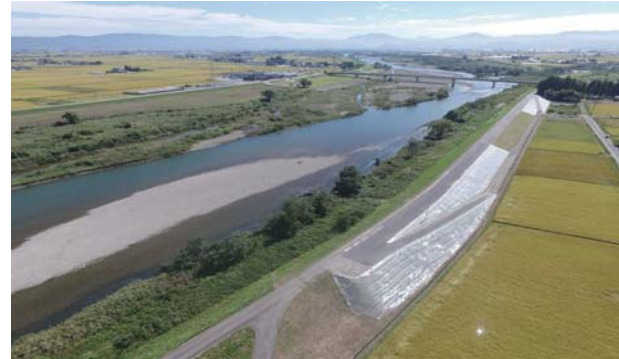
宮古弱小堤防 ICT施工範囲 L=132m
